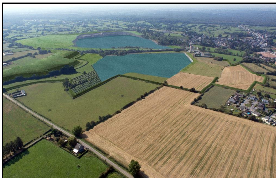
Remise en état du site – Vue depuis le nord-est
